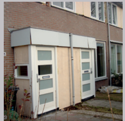
Werk in uitvoering
